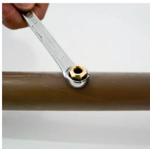
Figura 1: instalação do porta sensor
