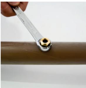
Figura 1: instalação do porta sensor
